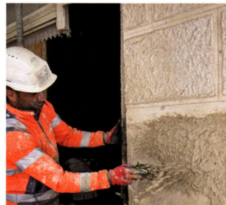
Réalisation des enduits du soubassement, © E. Georges
